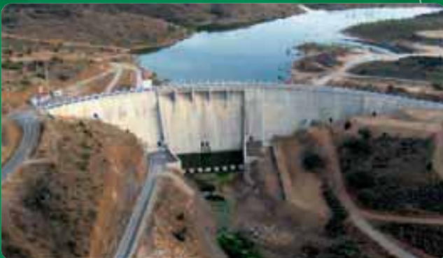
Córdoba. Presa de La Colada.
