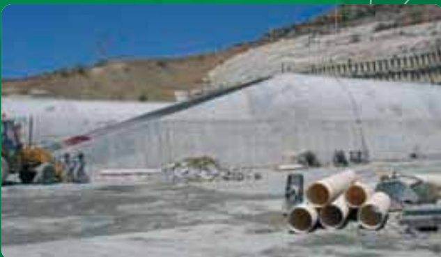
Tramo AVE Málaga.
