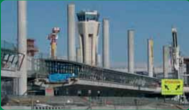
Ampliación Aeropuerto de Málaga.
