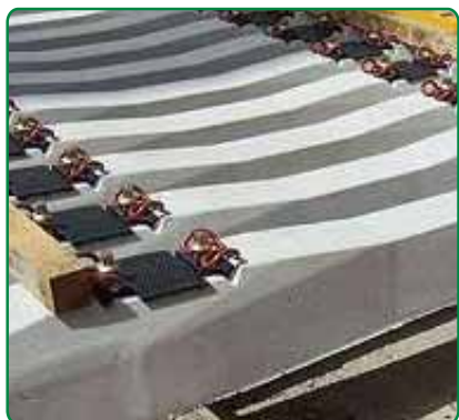
Vía del AVE, Puente Genil (Córdoba)
