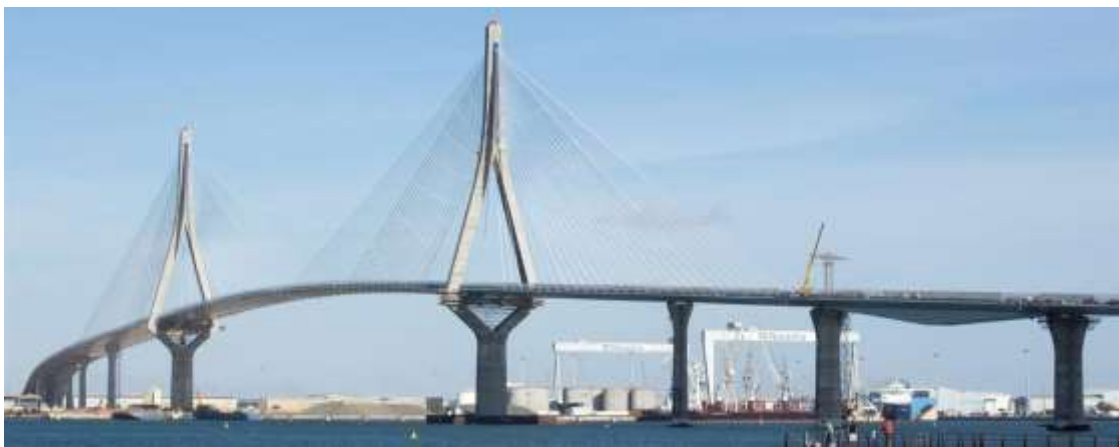
Puente de la Constitución de 1812 de Cádiz
